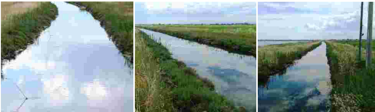
Figura 5, 6; 7. Foto dei canali di carico /scarico: C1, C2, C3.
